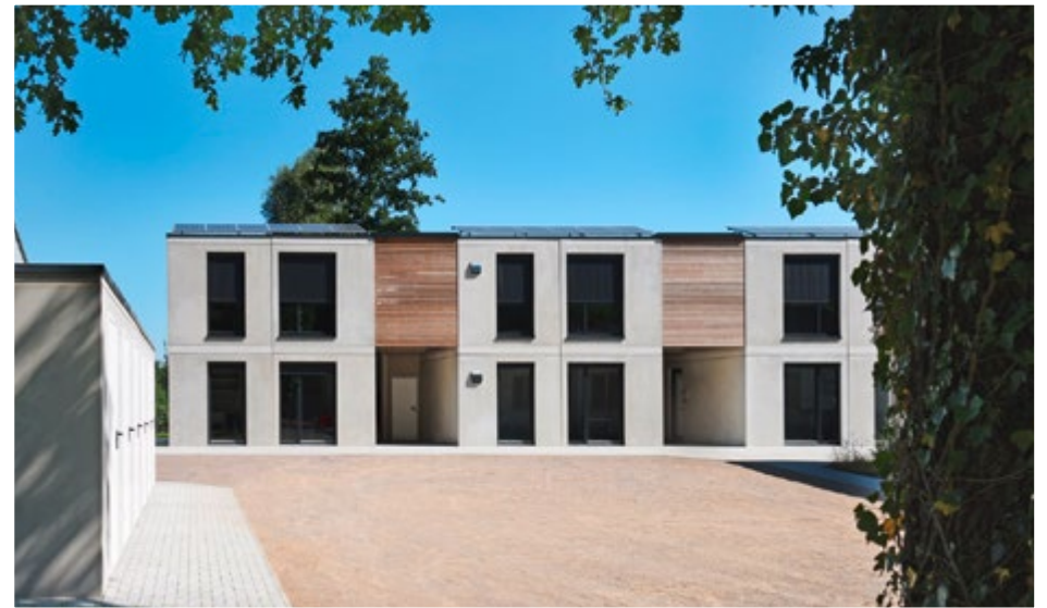
SCHÖPPINGEN: Nachhaltige Flüchtlingsunterkünfte energieeffizient mit bedarfsgerechter Lüftungstechnik
