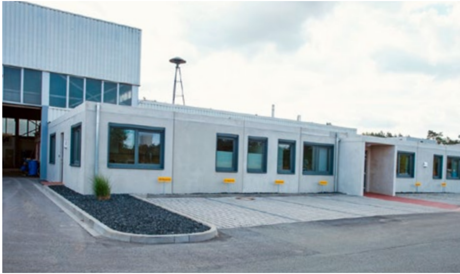
LINGEN: Bürogebäude mit optimalen Arbeitsplätzen und jederzeit erweiterbar
